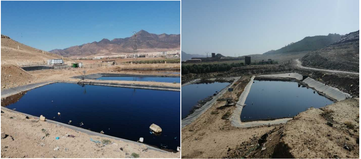
Figure 07 : Bassins des lixiviats
