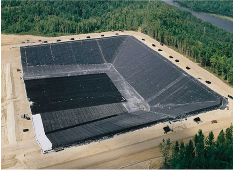
Figure 02 : Géomembrane imperméable en polyéthylène haute densité pour le projet d'enfouissement (made in china, 2023)
